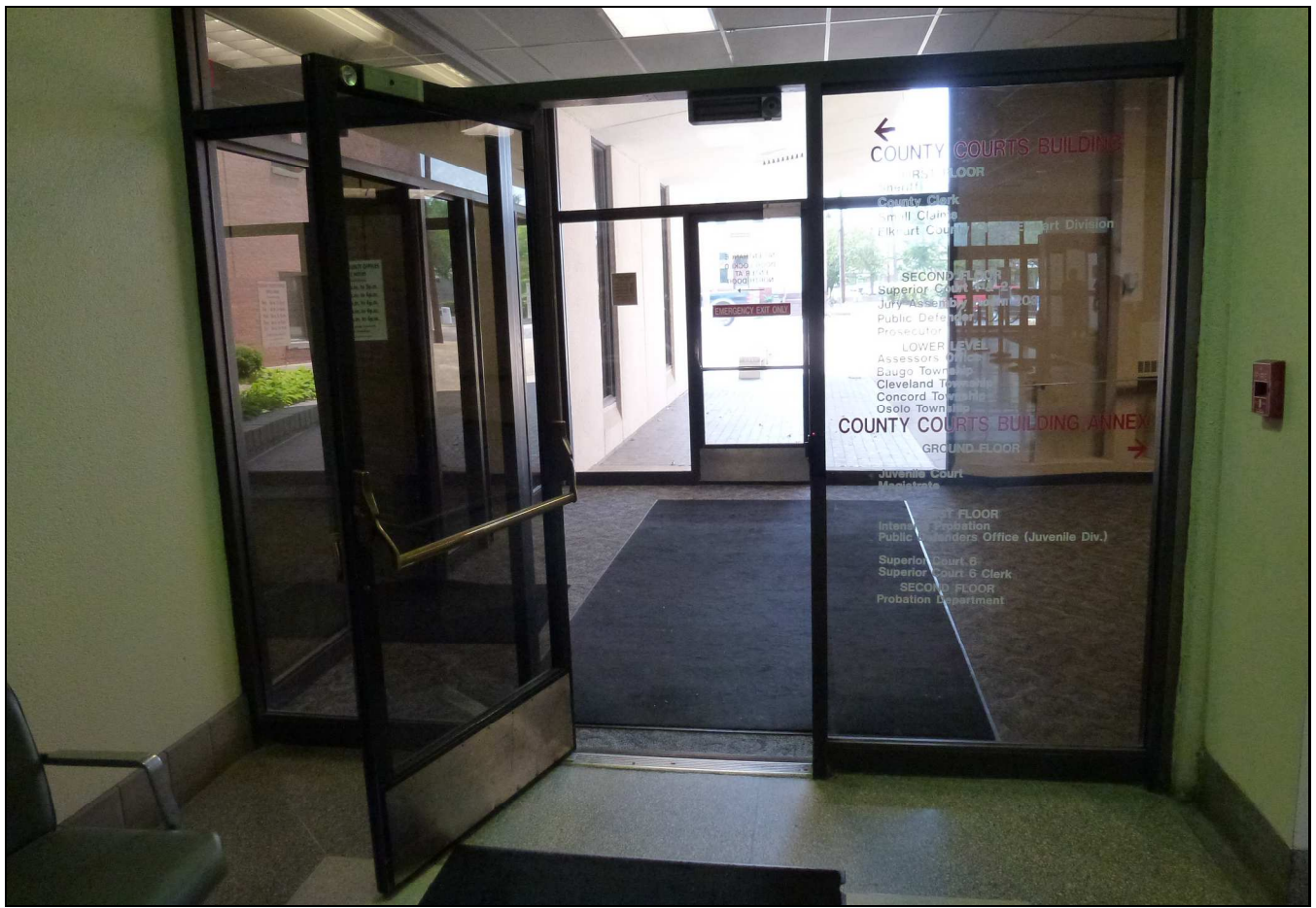
03. Elkhart Courts Bldg Doorway
